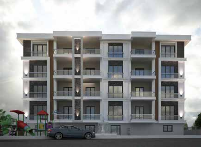
SAN Yapı - AFYON
